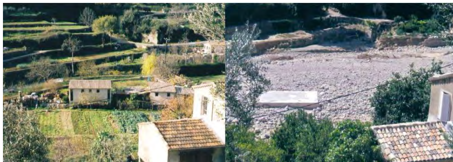
Figure 5 – Maison construite près de la Nartuby à Rebouillon (avant et après la crue)
