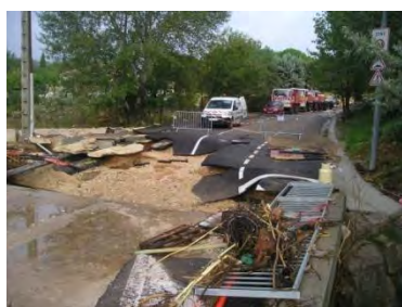
Figure 11 - Photographie des dommages constatés sur la commune de Grabels suite aux inondations d'automne 2014 (SYBLE)
