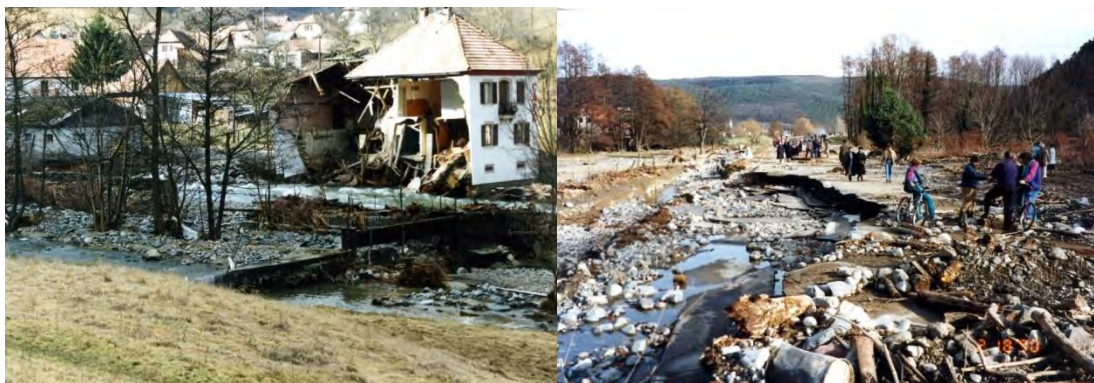
Figure 1 : Maison et route détruites par la crue de la Lauch, dans la vallée de Guebwiller, le 14 février 1990
