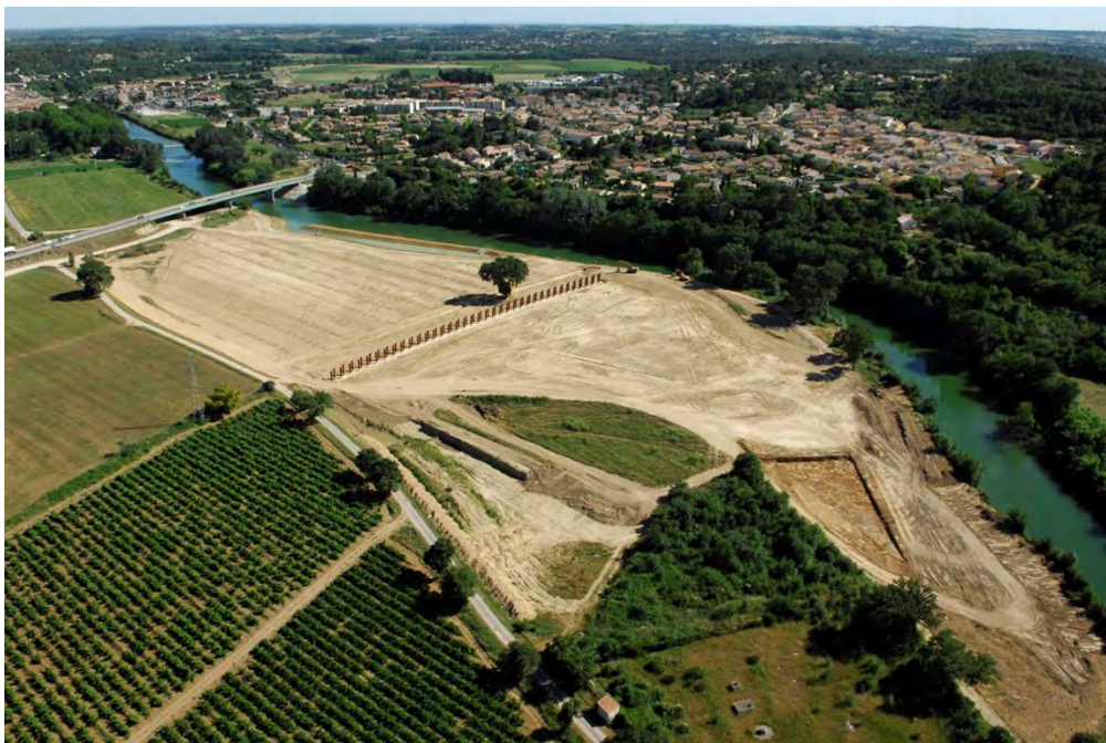
Fig. 15 – Zone d’expansion de crue et peigne à embâcles (EPTB Vidourle)
