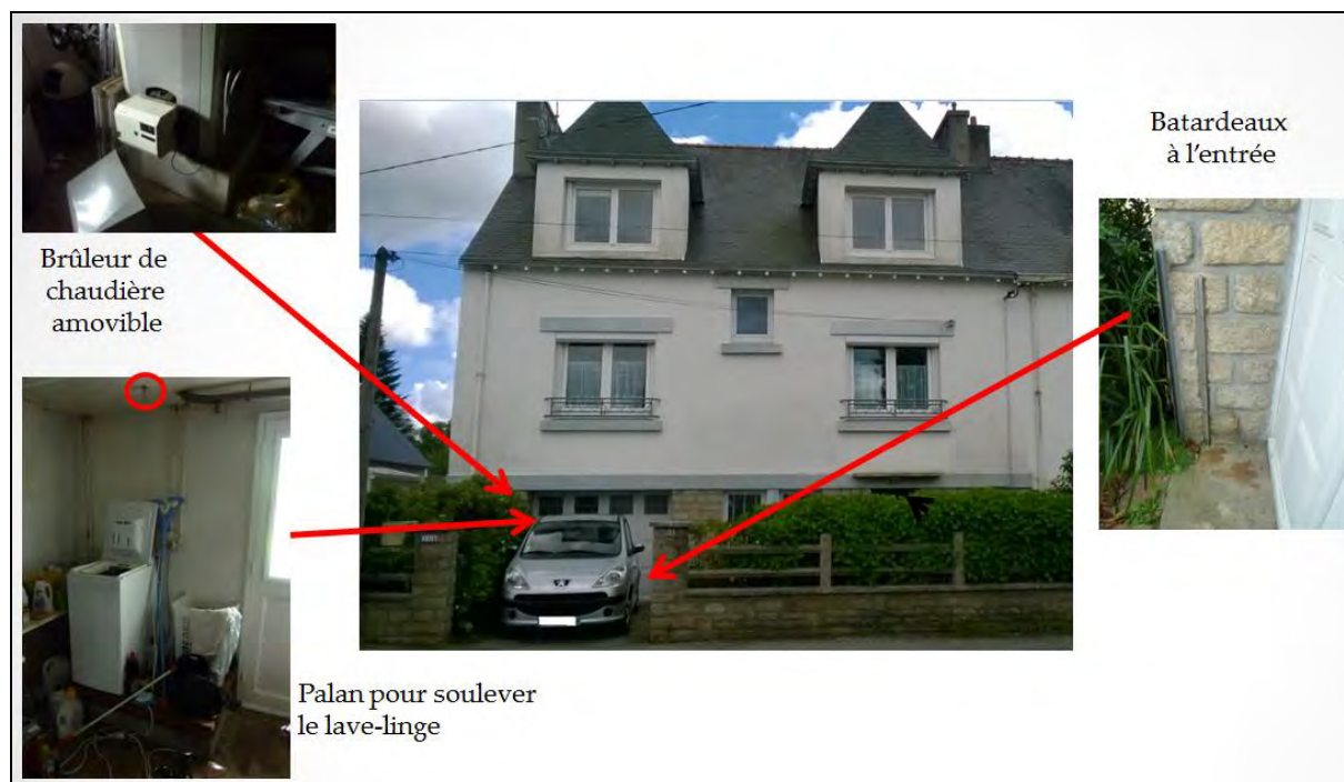
Fig. 7. Un exemple d'adaptation du bâti à l'inondation déjà en place dans le quartier de l'Hippodrome à Quimper.
