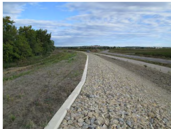
Fig.13 – Vue de la poutre de calage et des Gabions (EPTB Vidoule)
