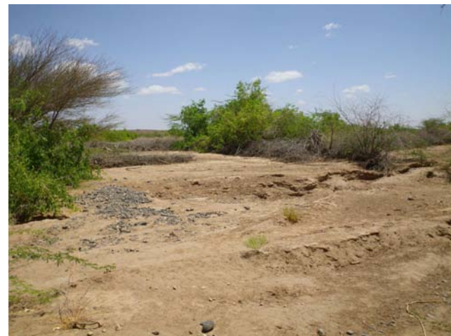
Perte par engravement et affouillement
