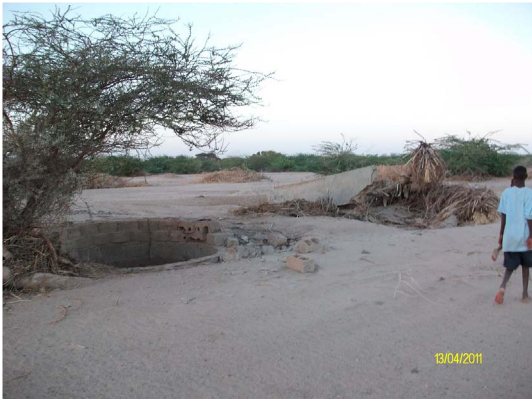
Photographie 17 : Destruction totale de terres agricoles et d'un puits par affouillement et dépôt d'alluvions sableuses à Garaytou. On notera que ce secteur a déjà été fortement endommagé par des crues plus anciennes.
