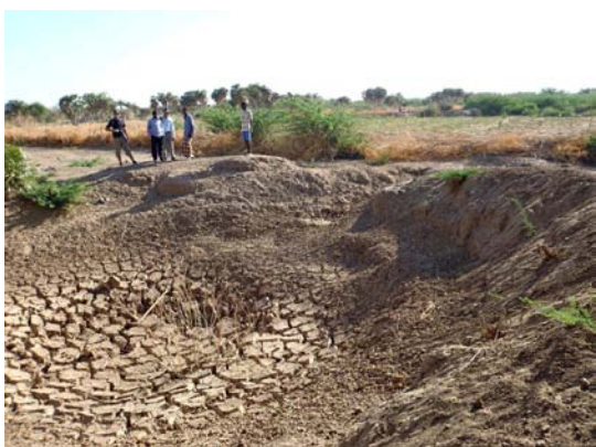
Puits en partie comblé
