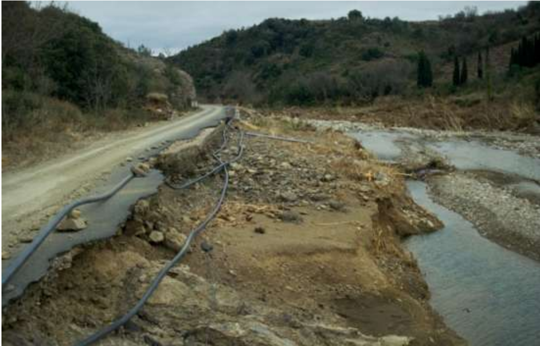
Photo 1 : route coupée par la crue de la Berre à l'amont de Durban-Corbières (Aude).
