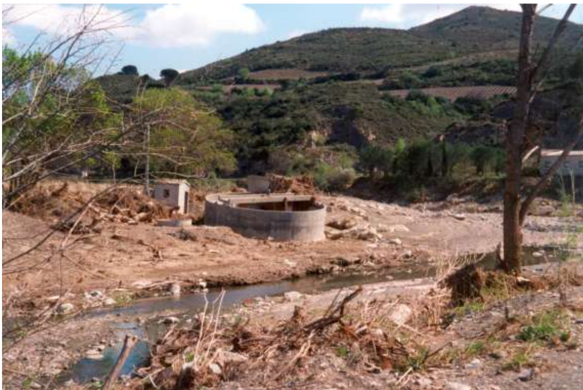
Photo 2 : La station d'épuration de Villeeneuve-des-Corbières mise hors-service par la crue de la Berre (Aude) (cliché : M. Normand)
