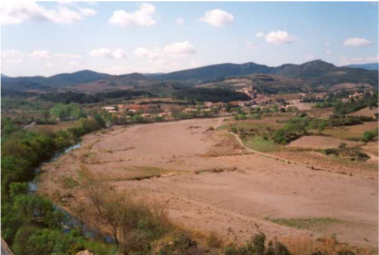
Photographie 2 : engravement du lit majeur de la Berre à l'aval de Durban-Corbières. L'eau est montée au-delà de la route à droite de la photographie.
