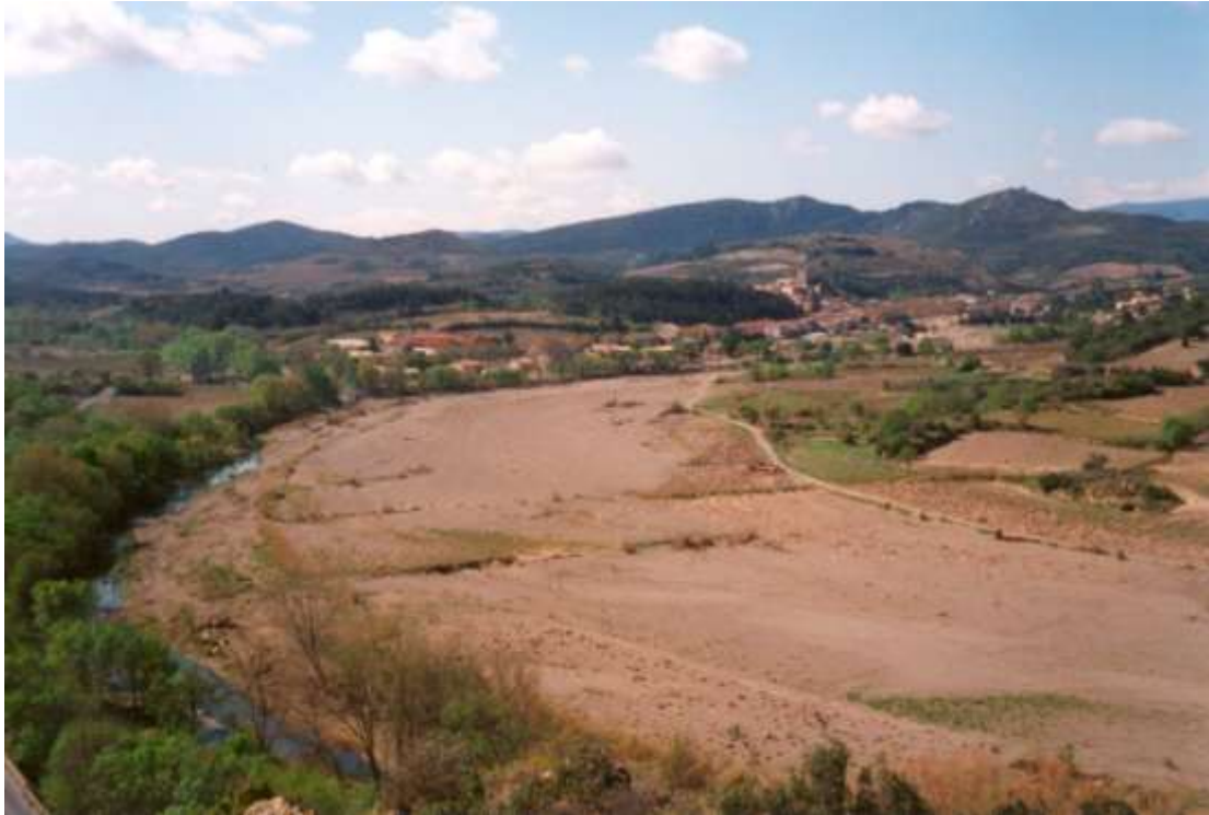
Photo 1 : L'engravement du lit majeur de la Berre à l'aval de Durban-Corbières (Aude).
