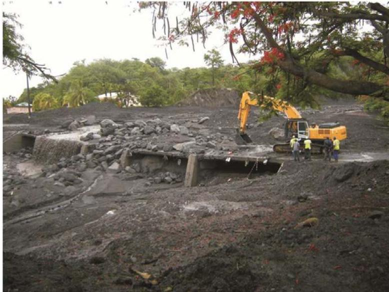
**Figure D3 – Le pont de la Rivière du Prêcheur détruit par le lahar du 20/06/2010
