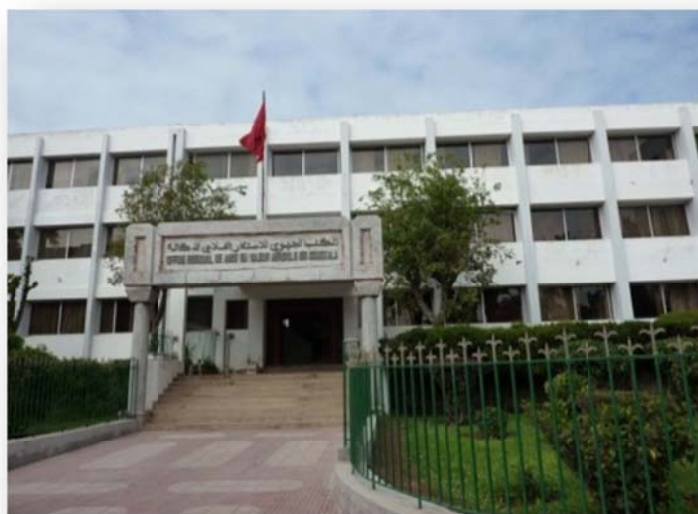
Figure E11 : Bâtiment administratif (Lagahé & Péroche, 2010).
