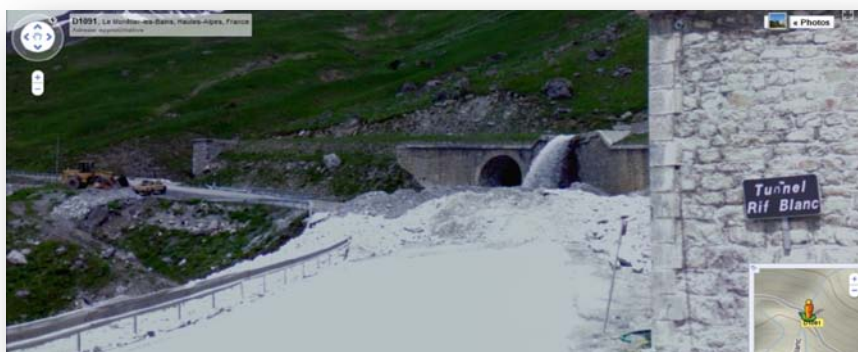
Figure A4 - Exemple d'obstruction de chaussée par une lave torrentielle. Torrent du Rif Blanc, Hautes-Alpes (capture d'écran de Google Street View, 2010)
