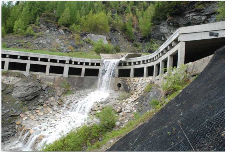
Figure E17 - Aménagement de protection de la route D902 contre les avalanches et les laves torrentielles du torrent Nan Cruet (73) (photo. F. Leone F. 2010)
