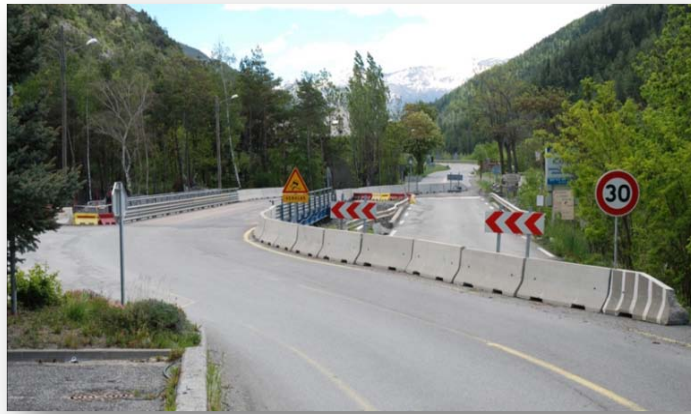
Figure A6 - Exemple de perturbation fonctionnelle (ralentissement) liée au remplacement d'un pont endommagé avec itinéraire de contournement suite à une lave torrentielle (07/2009). Torrent de l'Abéous, vallée de l'Ubaye (photo F. Leone, 02/06/2010)
