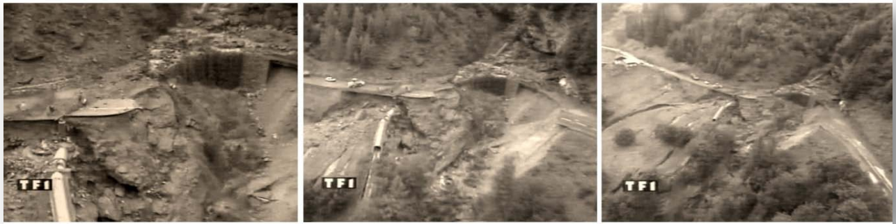
Figure E6 - Vues aériennes de la portion de la départementale 902 détruite près du lieu dit Piperon par une lave torrentielle le 24 juillet 1996 (Savoie) (source TF1, capture vidéo)
