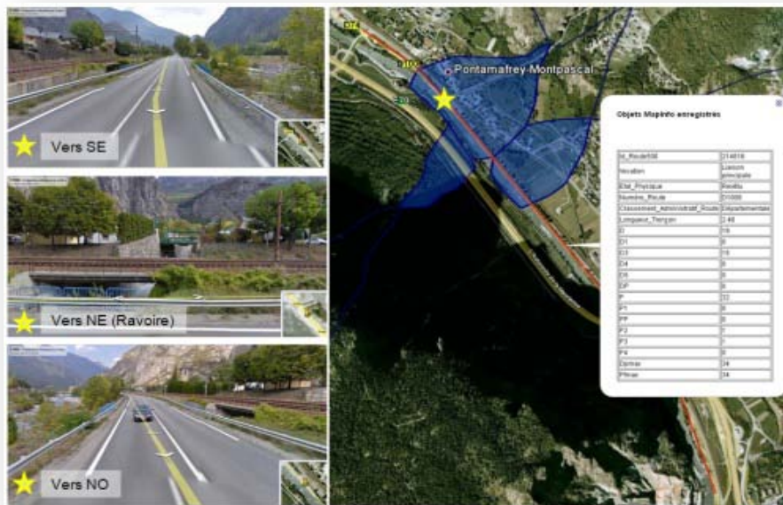
Figure B8 - Tronçon le plus exposé aux debris flows de la zone d'étude : D1006 sur un tronçon exposé aux laves torrentielles du torrent de la Ravoire (34 évènements), Savoie. (Capture d'écran GoogleEarth et Google Map, sources BD BV LGP, BD impacts, BD Route500 IGN). En rouge : tronçon, en bleu : limites de bassins versants et cônes de déjection)
