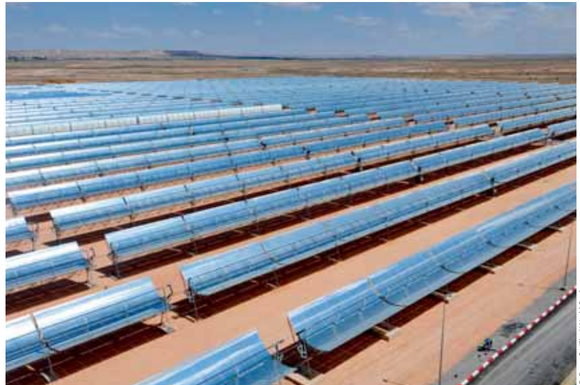
Centrale thermo-solaire au Maroc.
